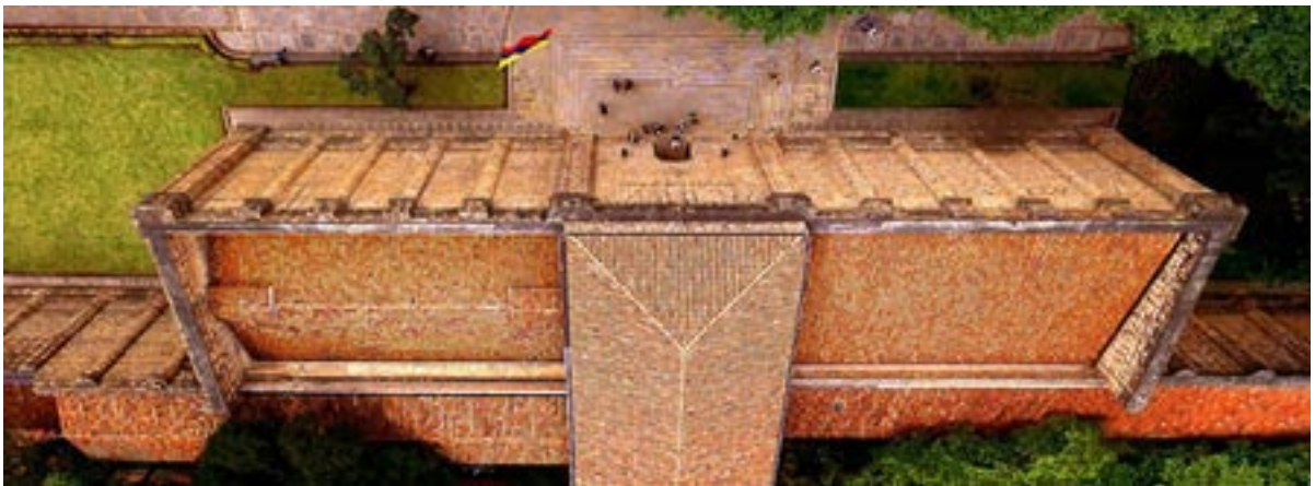
Ilustración 14a Vista aérea actual.
