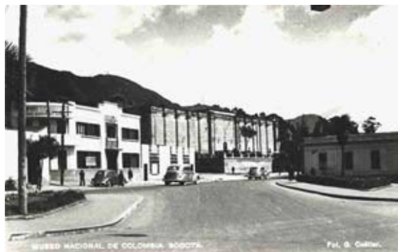
Ilustración 14b Vista exterior del Panóptico cerca de 1950. Se puede observar la superficie elevada que limita con el andén de la séptima y la balaustrada que circunscribe la plazuela 40 .
