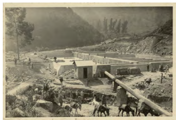
108 | Fernando Carrizosa Valenzuela (1881 - 1947) | CONSTRUCCIÓN PLANTA DE VITELMA. ACUEDUCTO DE SAN CRISTÓBAL | 1924
